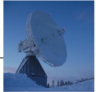
Telemetry, Tracking & Command Station Kiruna, Suède - Crédit ESA
